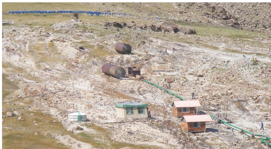
Рис. 5.11. Участок сбора, накопления и перекачки термальных вод для санаторно-курортного потребления (фото автора, 2019)
