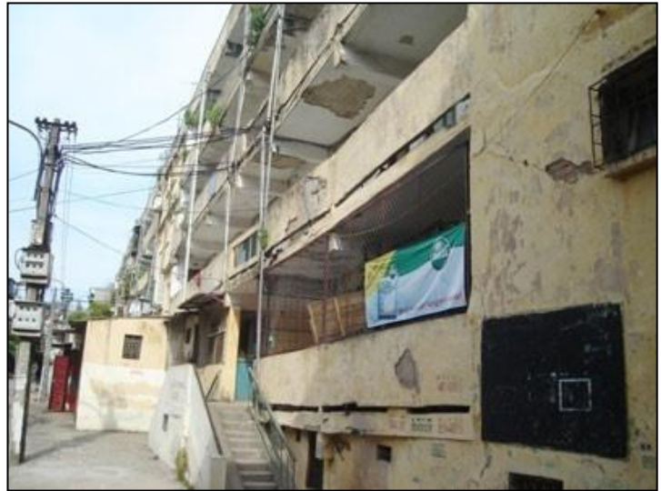
Рисунок 1.8. Здание А2 (слева) – Нгокхань, построенное в 1976 г., с вертикальной деформацией 80 см и неравномерной деформацией 45 см (фото: Фи Х.Т., 2012) и здание С1 (справа) – Тханьконг, построенное в 1978 г., с вертикальной деформацией 200 см [82]
