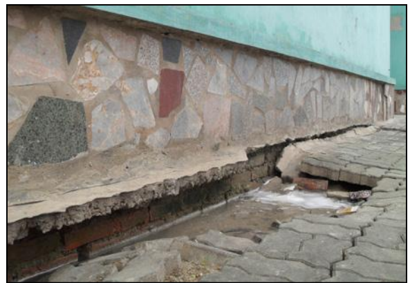
Рисунок 1.9. Отмостка здания, построенного в 2007 г. в микрорайоне Тхиньлиет района Хоангмай города Ханоя, опустилась ниже [92]
