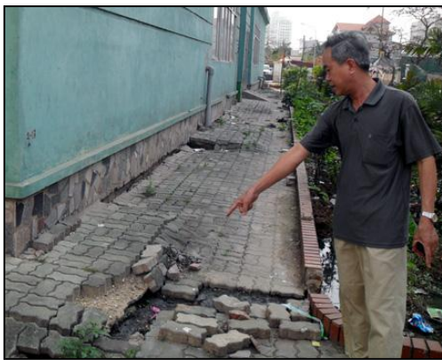
Рисунок 1.9. Отмостка здания, построенного в 2007 г. в микрорайоне Тхиньлиет района Хоангмай города Ханоя, опустилась ниже [92]
